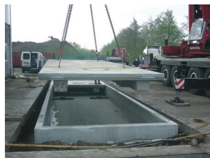
Einheben der Brücke
