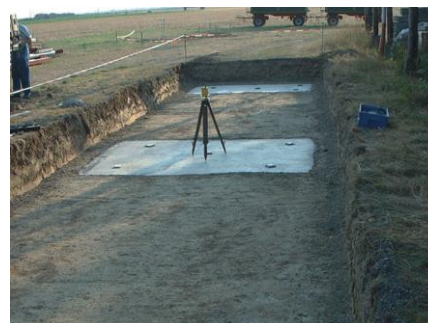
Aushub mit Streifenfundamenten
