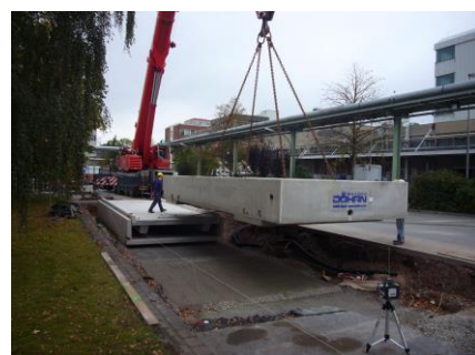
Aushub und Tragschicht aus Kies/Schotter für Ausführung EFS
