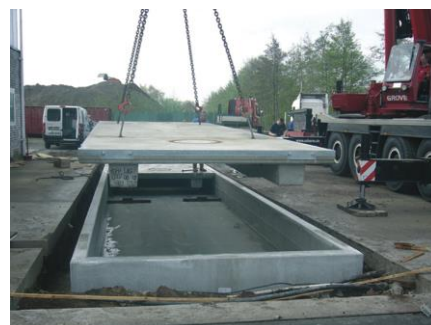
Einheben der Brücke
