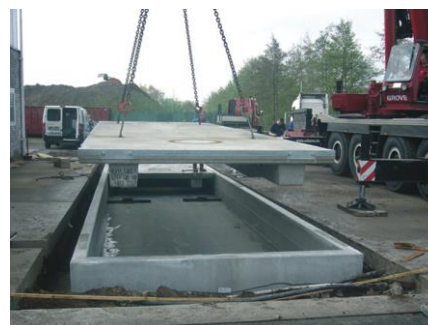
Einheben der Brücke
